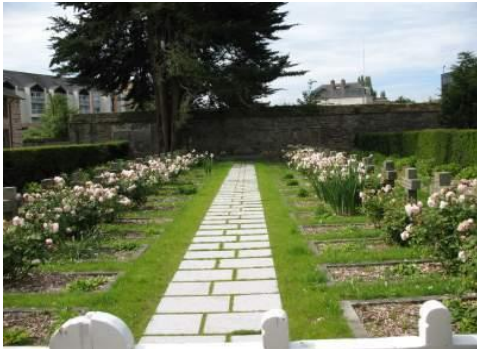
Photo 7. Dalles avec joints gazon Cimetière Saint-Cyr (Rennes)
