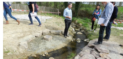
Les enrochements permettent de s'asseoir au bord du ruisseau et en sécurisant l'accès.
