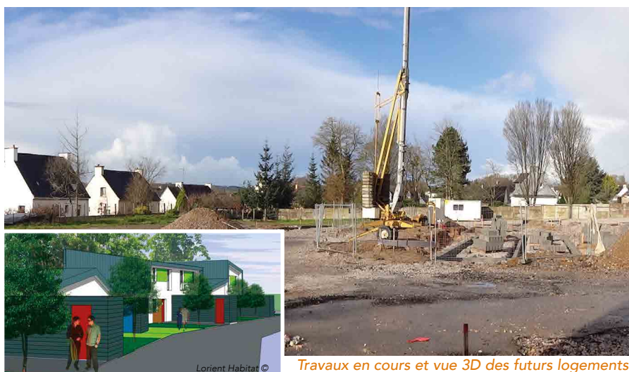
Travaux en cours et vue 3D des futurs logements.
