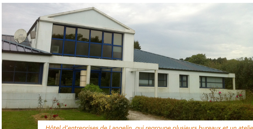
Hôtel d'entreprises de Langelin, qui regroupe plusieurs bureaux et un atelier
