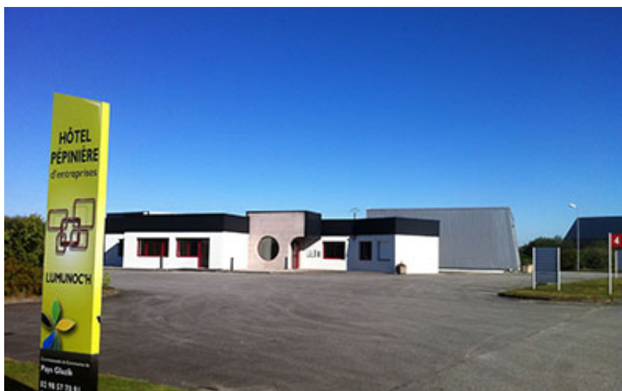
21 bureaux et 4 ateliers en location sont regroupés dans cet hôtel-pépinière d'entreprises
