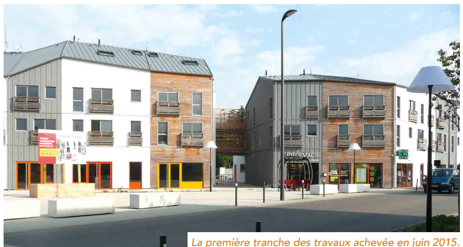
La première tranche des travaux achevée en juin 2015.
