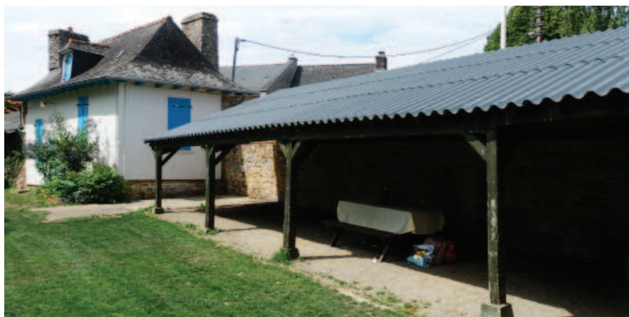
Au pied de l'étang, près du camping, un espace de guinguette pourrait remplacer cet appenti parfois utilisé pour des moments conviviaux
