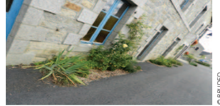
Végétalisation en pied de mûr.
