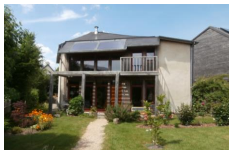
Maison individuelle construite en paille
