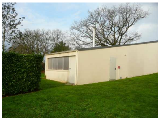
Bâtiment de la chaufferie bois
