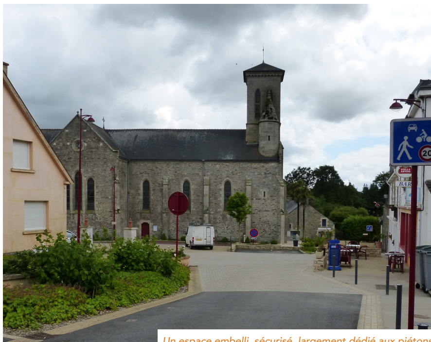
Un espace embelli, sécurisé, largement dédié aux piétons
