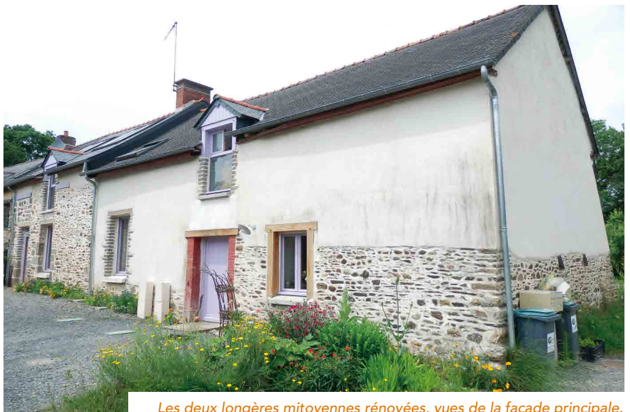
Les deux longères mitoyennes rénovées, vues de la façade principale.
