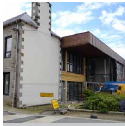
La Mairie en travaux côté centre ville.
