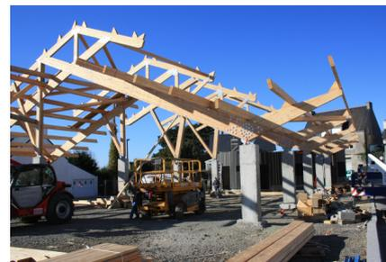
La halle en construction avec les piliers de granit et la charpente en bois
