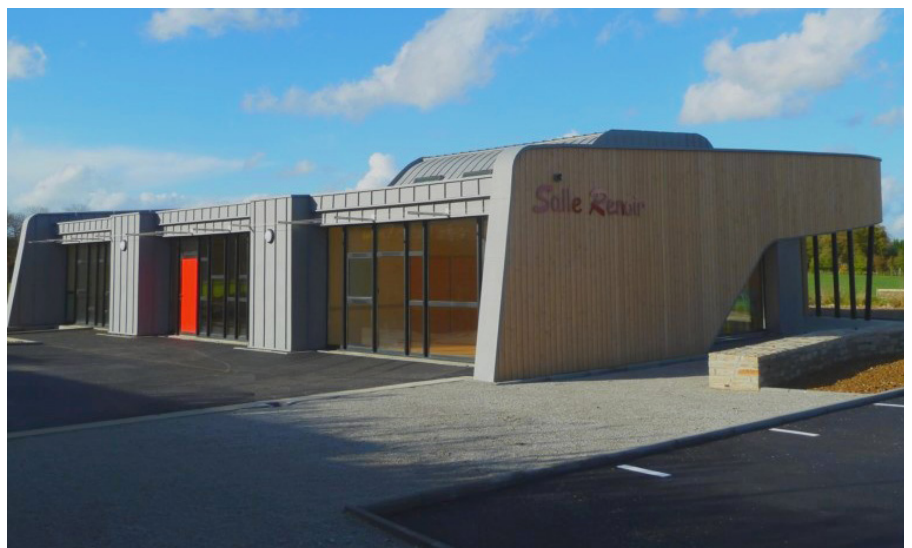
La forme compacte de la salle Renoir permet de limiter l'emprise foncière et de favoriser les performances thermiques du bâtiment
