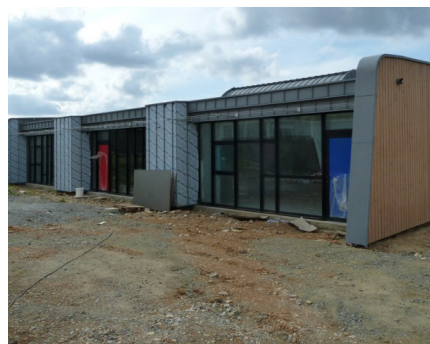
La façade vitrée au sud (ici en chantier) permet d'apporter un éclairage naturel et un confort thermique maximum
