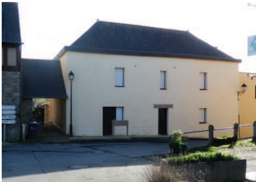
Les logements donnent directement sur la place de l'église, à deux pas des services et des commerces et à 5 minutes à pied de la station TER
