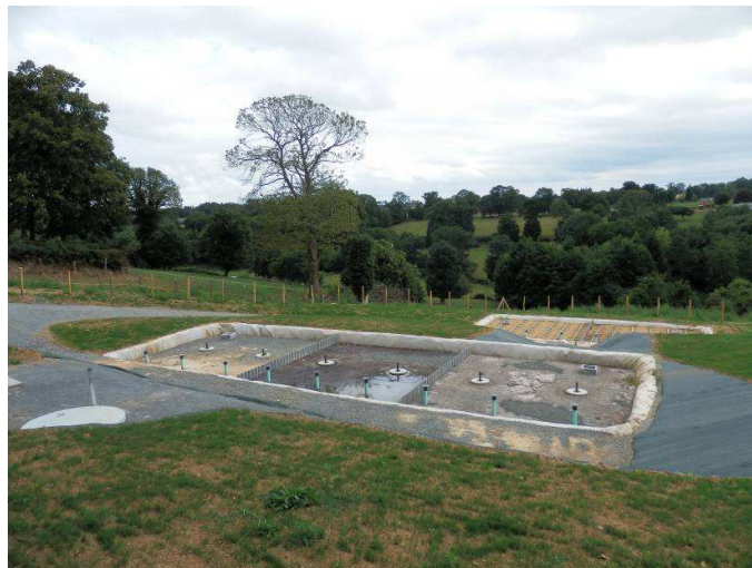
Après être passé par l'un des trois bassins du 1 er étage (premier plan), les eaux usées finissent leur épuration dans un 2 ème bassin, tous plantés de roseaux (au fond).
