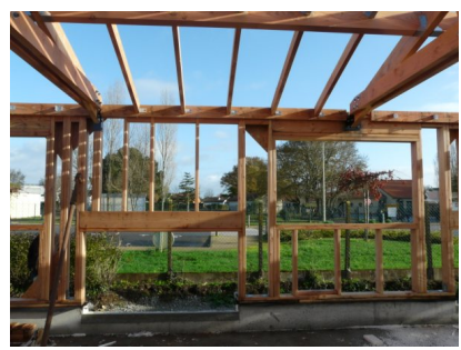
Ossature bois de la maison de l'enfance
