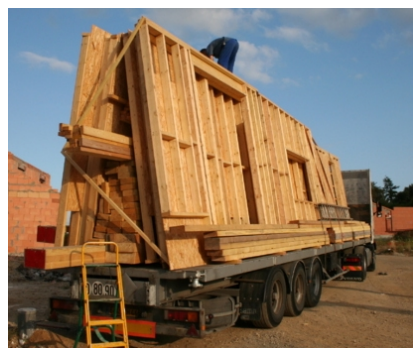
Camion transportant l'ossature d'une maison bois
