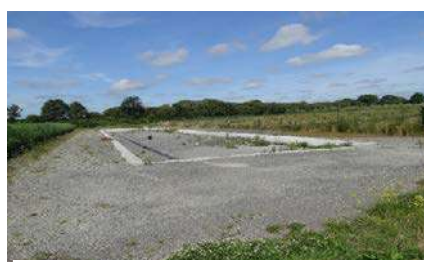
L'eau passe par un filtre à apatite qui est une roche « basique » dont la fonction est de réauler le pH (Bouvron-44)
