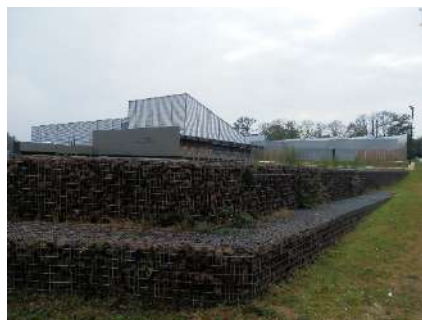
Gabions près de la salle culturelle et sportive de Laillé (35)
