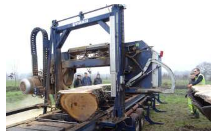
Une scierie mobile de Saint-Aubin d'Aubigné est venue débiter les chênes en planches et poutres directement sur le site.
