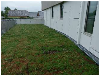
Toiture végétalisée sur la mairie de Breteil (35)
