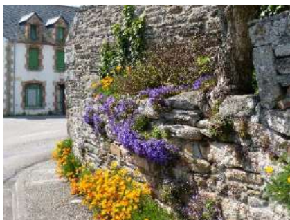
Les murs en pierre sèches permettent le développement de plantes voire d'arbres ! - Plovan (29)
