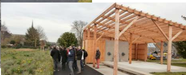
Construction d'un abri et de sanitaires
