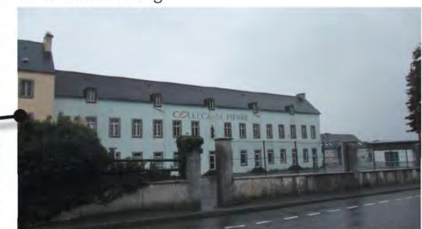
Le collège Saint-Pierre, des bâtiments voués à la démolition
