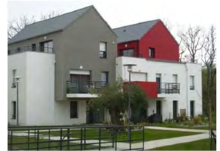
L'exemple de cet immeuble à Chantepie (35) illustre le principe de reprise des gabarits existants.
