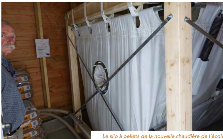
Le silo à pellets de la nouvelle chaudière de l'école
