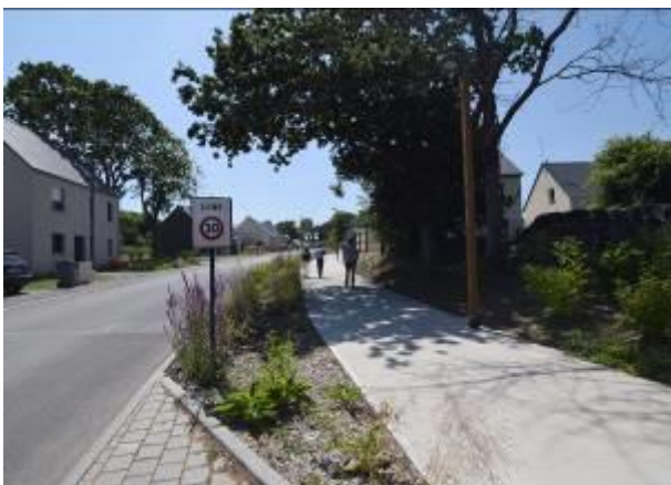
Figure 6 : Système de noues végétalisées et éclairage public orienté sur le cheminement (ZAC du Clos Loquen). © Gilles LECUIR
