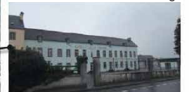
Le collège Saint-Pierre, avant sa démolition
