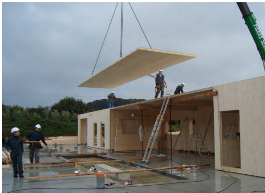
Montage - assemblage des panneaux de bois contre-collés préfabriqués
