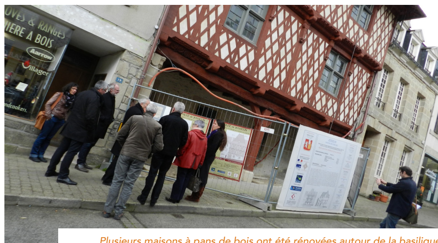
Plusieurs maisons à pans de bois ont été rénovées autour de la basilique
