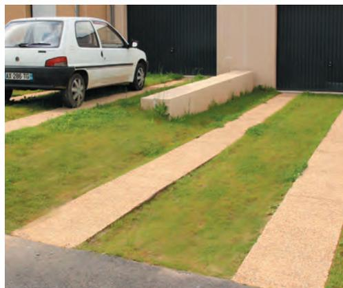
Bandes de roulement en béton sur zone engazonnée
