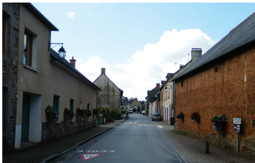
La commune dispose d'un patrimoine en terre remarquable que la municipalité entend non seulement mettre en valeur mais développer
