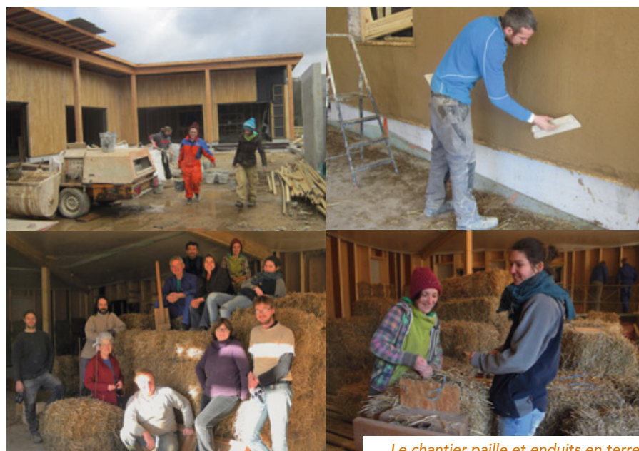
Le chantier paille et enduits en terre.
