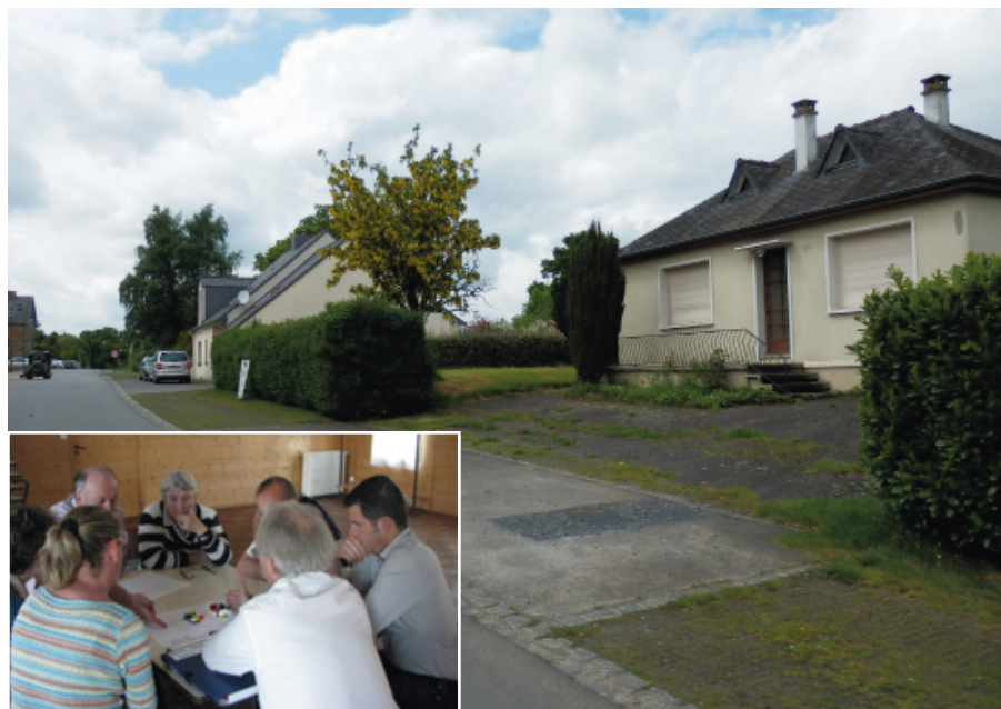
L'opération, associant élus, Néotoa, équipe de Moe et voisins, a permis de démolir une maison de piètre qualité et de recréer un front bâti dans la continuité des maisons existantes
