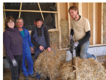
Bénévoles et ouvriers sur le chantier paille.
