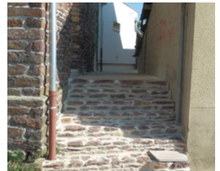
Un escalier en pierre a été aménagé pour accéder au bâtiment par le côté droit
