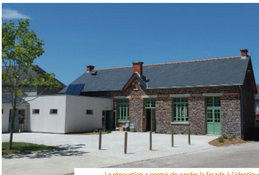
La rénovation a permis de garder la façade à l'identique
