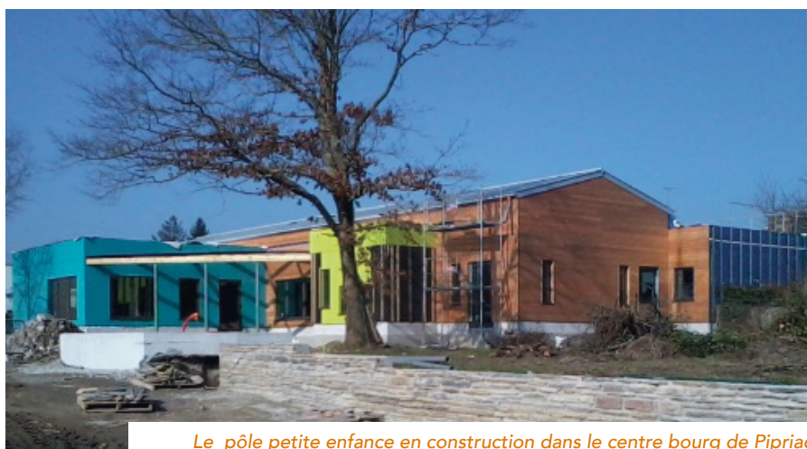
Le pôle petite enfance en construction dans le centre bourg de Pipriac
