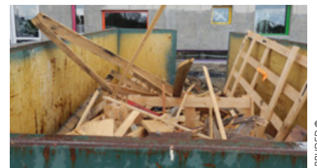
Dans le DCE, un tri des déchets de chantier a été exigé
