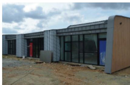
La façade vitrée au sud (ici en chantier) permet d'apporter un éclairage naturel et un confort thermique maximums
