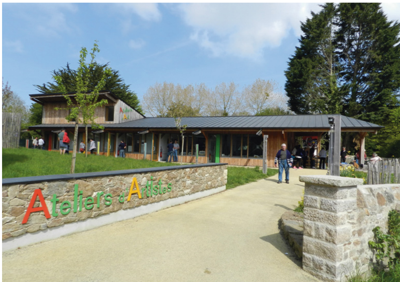
À Plessix-Balissou (22) , l'accompagnement d'Abibois de la conception jusqu'au suivi des entreprises a permis à la communauté de communes de la Côte d'Emeraude d'utiliser du bois local pour construire les ateliers d'artistes.
