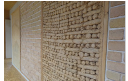
Les murs de parement en BTC, bauge et pisé
