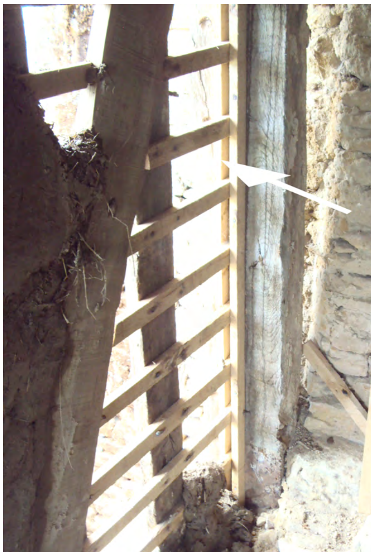
Illustration 14: Doubles contre-lattes ou contre-tasseaux en Normandie (Aurélie Le Pape)
