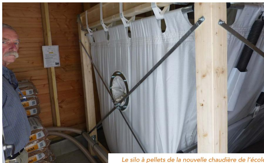
Le silo à pellets de la nouvelle chaudière de l'école
