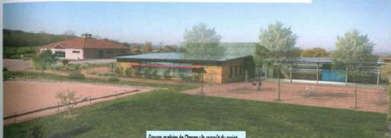
Groupe scolaire de Changy : le succès du projet au BEC Énergie 2013 est de 10 % par rapport à la réglementation thermique 2012.
