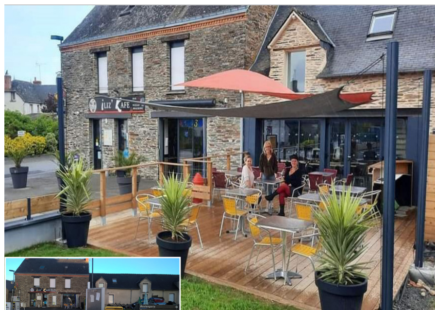
L'iliz Kafé et sa salle de restauration aménagée dans la maison mitoyenne. En médaillon, l'état avant travaux.
