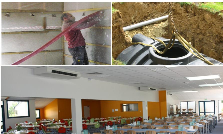
Isolation en ouate de cellulose, récupération de l'eau pluviale pour alimenter les sanitaires, protections acoustiques, puits de lumière... pour un bâtiment sobre et confortable !
