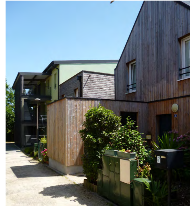
▶ Abris de jardin - cellier accolés à la construction - en façade sur accès principal La Chapelle Thouarault - ZAC de la Niche aux Oiseaux - Agence Sitadin
