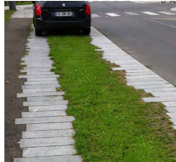
► Exemples de traitement de la placette de stationnement en revêtement perméable
