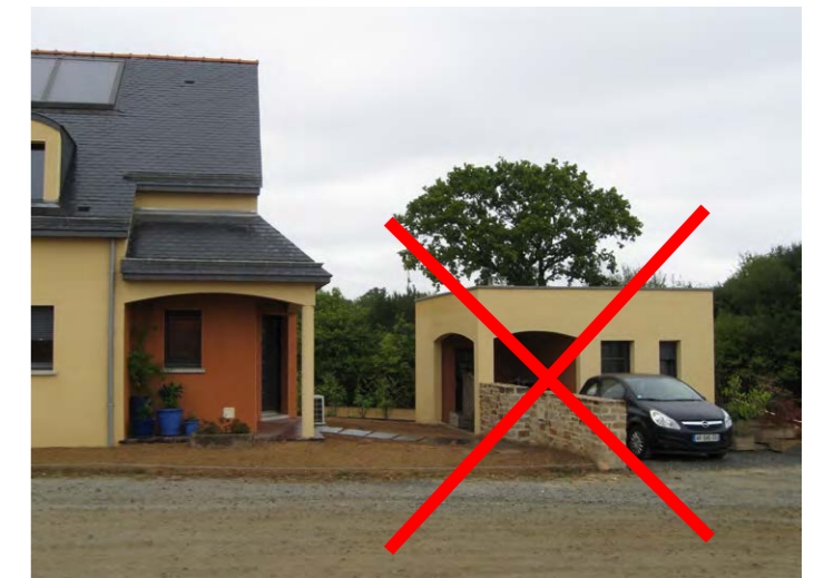
▶ Exemple d'abri de garage/cellier non autorisé.
