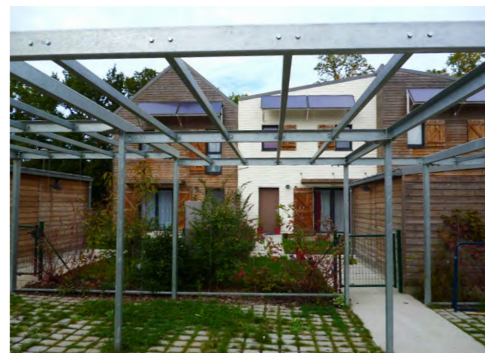
► Exemple revêtement pavé-joint gazon sous car-port
