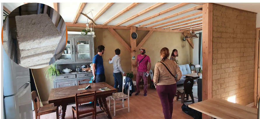
La terre crue occupe une place importante dans les maisons. Des ouvrages en partie réalisés par les acquéreurs lors de chantiers participatifs encadrés par la SCOP L'Aronde pour les ouvrages de maçonnerie en terre et Alison Hilton pour les enduits.
