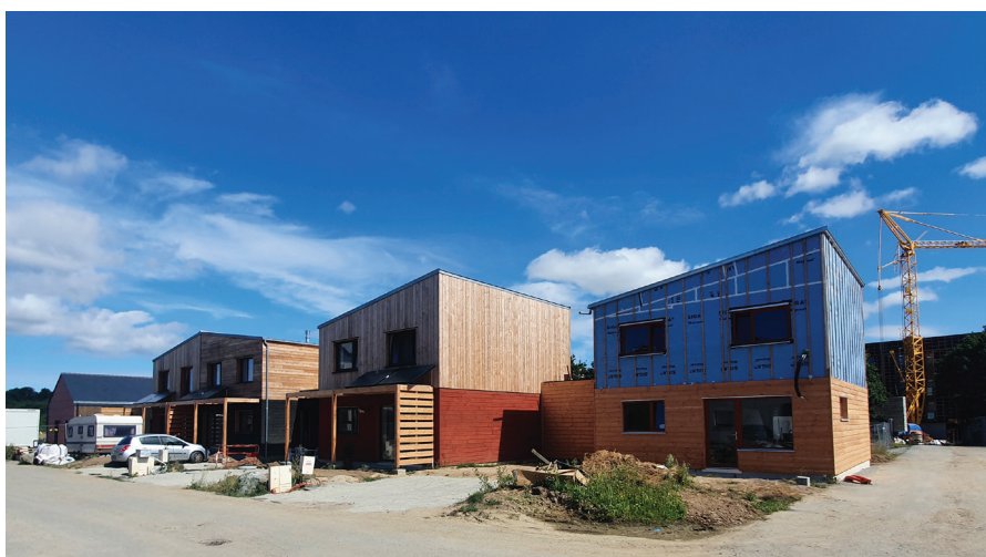
Les 4 maisons EKOLOKO en juillet 2022, la dernière en chantier sera finalisée en septembre
