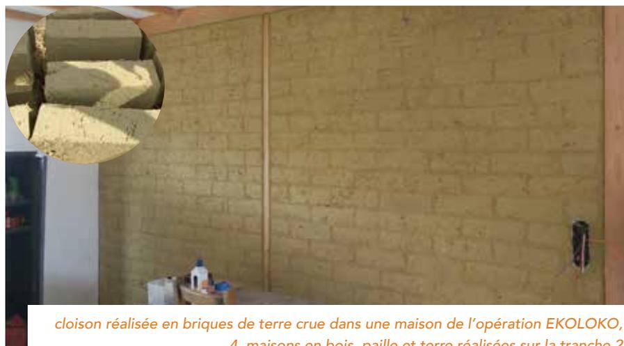
cloison réalisée en briques de terre crue dans une maison de l'opération EKOLOKO,
