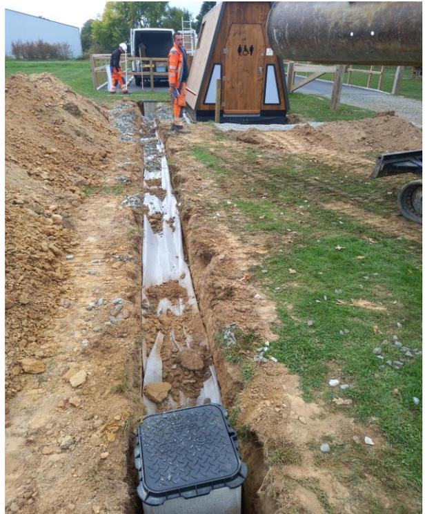
Finalisation de la tranchée drainante avec la pose du géotextile
