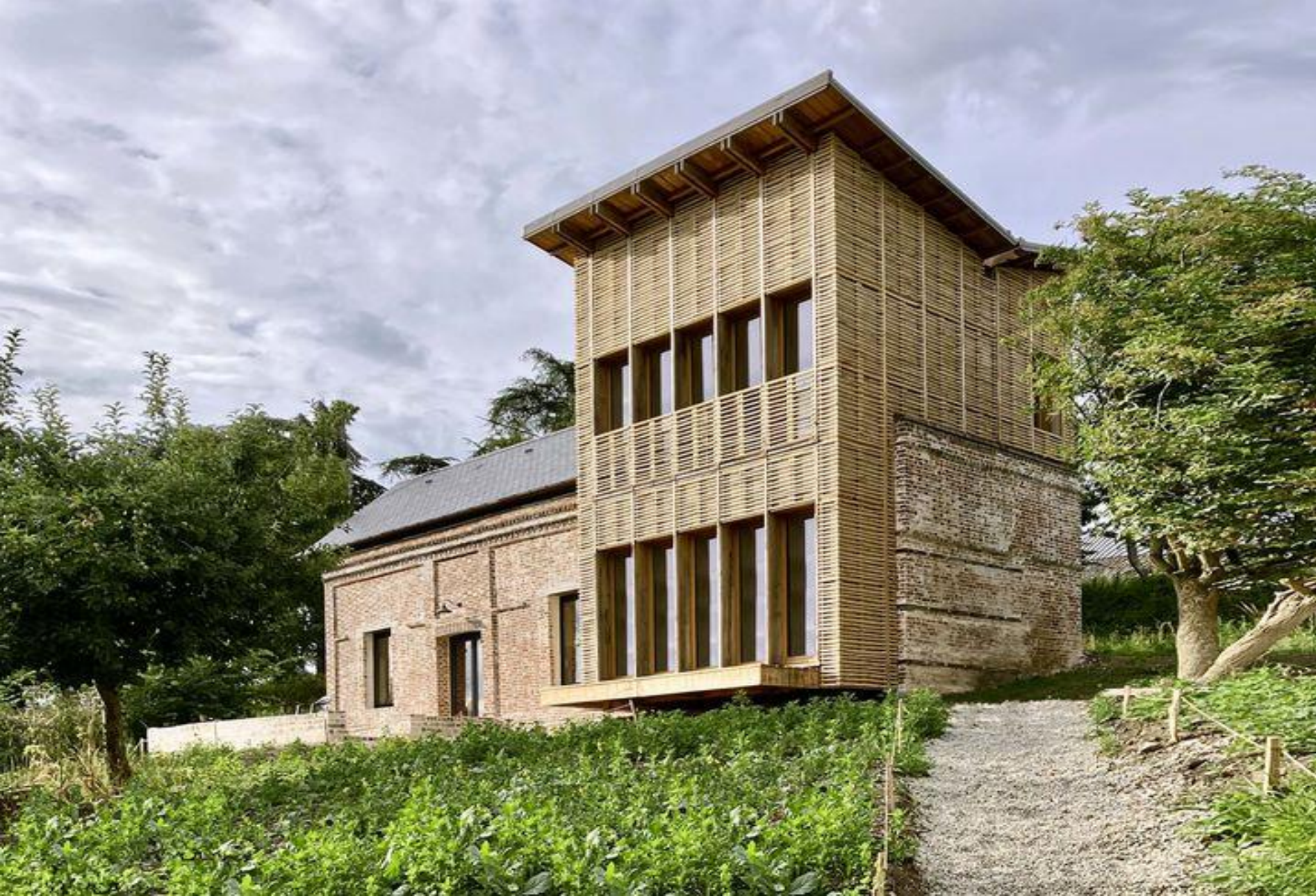
Réhabilitation d'une habitation existante Sap en Auge (Normandie) Anatomies d'Architecture
