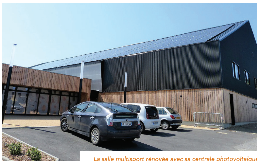
La salle multisport rénovée avec sa centrale photovoltaïque
