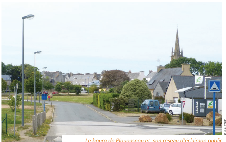
Le bourg de Plougasnou et son réseau d'éclairage public
