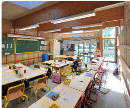
En absorbant la vapeur d'eau formée par les enfants, les murs de terre crue assurent une régulation hygrométrique
