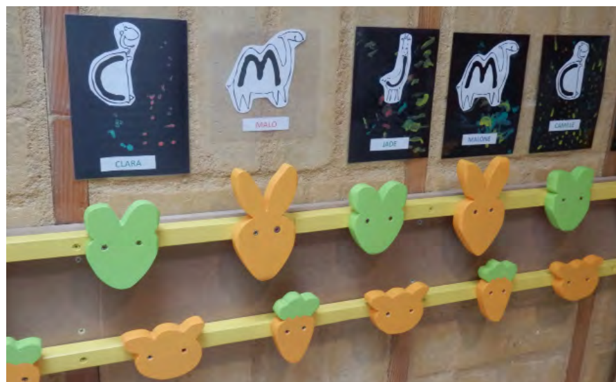
Briques de terre crue réalisée avec la terre des fondations, et mobilier de récupération donnent une chaleur unique à l'école
