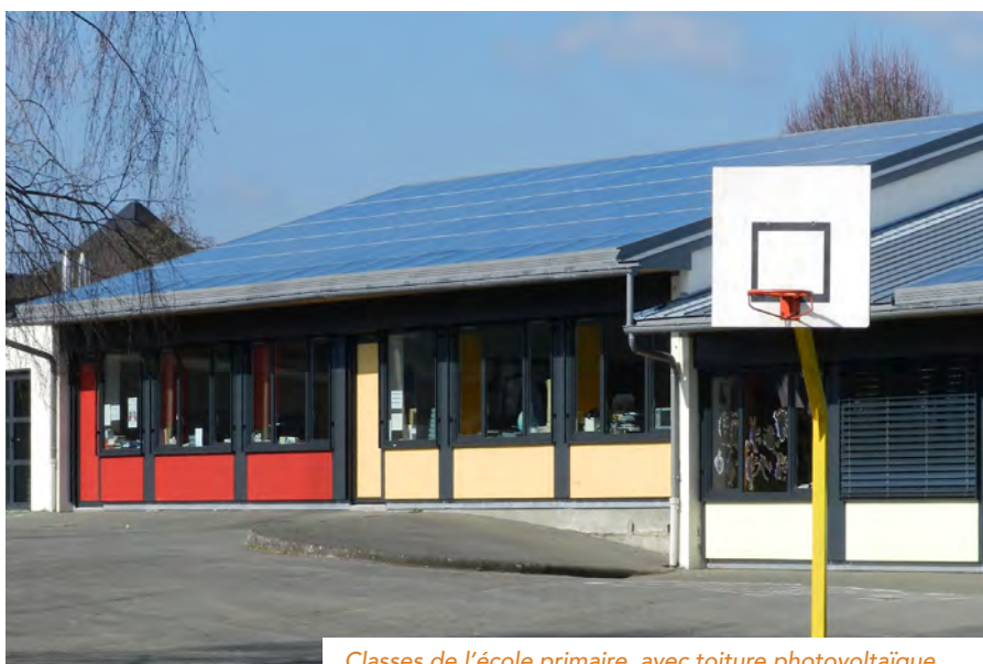
Classes de l'école primaire, avec toiture photovoltaïque
