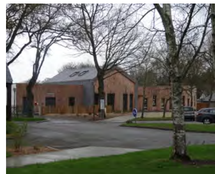
La façade de l'école, toute bardée de bois
