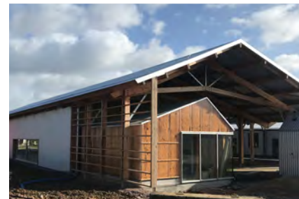
L'isolant en fibre de bois visible à travers le bardage transparent à fins pédagogiques.
