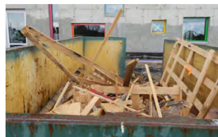
Dans le DCE, un tri des déchets de chantier a été exigé
