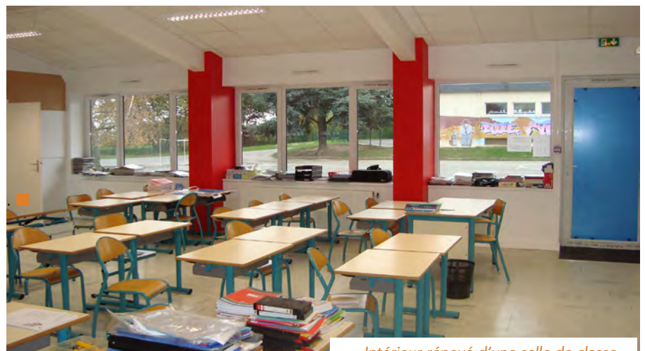
Intérieur rénové d'une salle de classe
