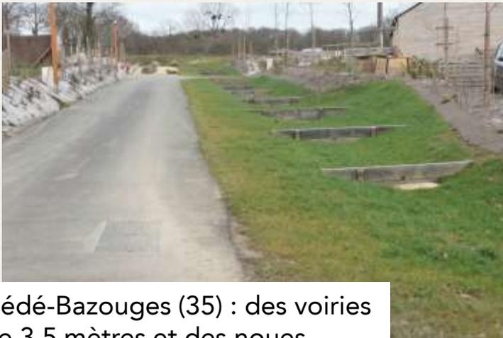
Hédé-Bazouges (35) : des voiries de 3,5 mètres et des noues d'infiltration
