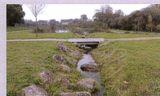
Passerelle permettant de franchir le cours d'eau, étang du Govéro à Monterblanc.
