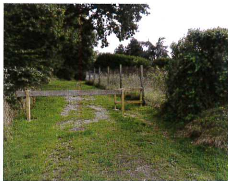
2) Chemin reliant la salle polyvalente et l'aire de service pour les camping-cars › chemin bordé d'un côté par un talus planté d'arbres et de l'autre par un grillage qui clôture le site de l'ancienne station d'épuration.
