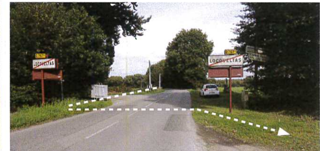
Entrée et sortie de l'agglomération : absence d'une continuité piétonne avec la future liaison douce vers Morbouleau.
