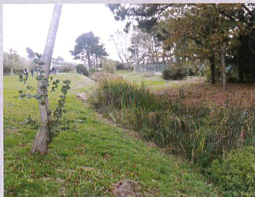
Ecoulement des eaux pluviales par un réseau de noues plantées de plantes épuratrices et de fossés à ciel ouvert favorisant l'infiltration et l'épuration des eaux.
