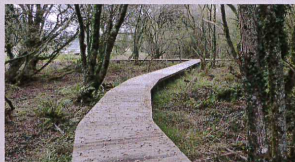
Réalisation d'un platelage sur pilotis dans une zone humide, étang du Govéro à Monterblanc.
