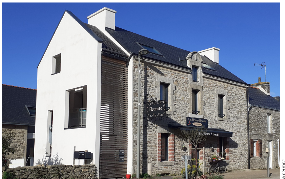
Création d'un escalier extérieur pour accéder aux logements à l'étage et commerce au RDC
