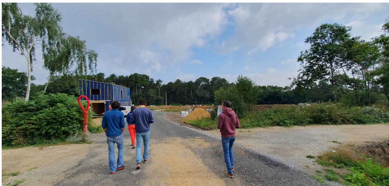
La tranche 3 en cours de réalisation.
