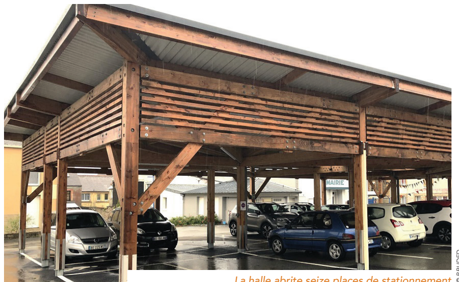
La halle abrite seize places de stationnement
