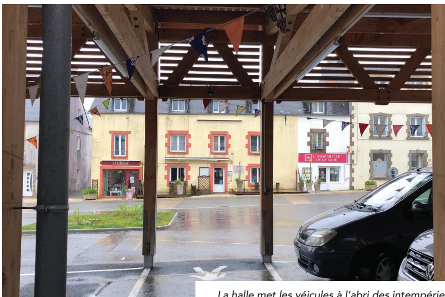
La halle met les véhicules à l'abri des intempéries
