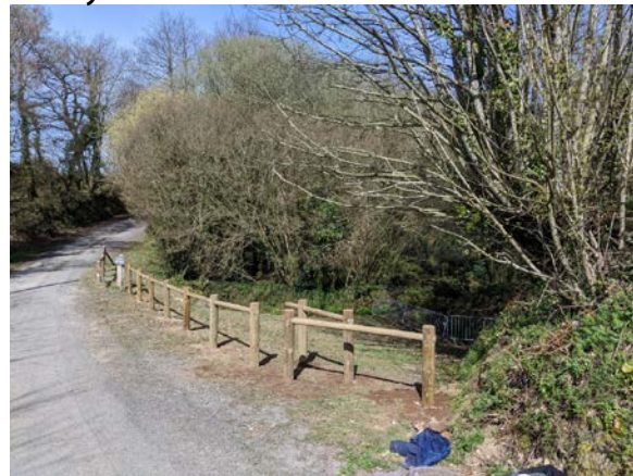
Installation de barrières à la fontaine de la chapelle Saint Divy
