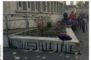
« Sous le bitume, la vie », c'est le nom du projet proposé par des parents d'élèves pour renaturer l'entrée de l'école. Le bitume a été retiré par bloc grâce à un découpage préalable. Ensuite, lors d'un chantier participatif, les blocs ont permis la réalisation de jardinières surmontées d'une assise en béton coulée sur place en régie. Les fosses remplies de terre ont ensuite été plantées. ■
