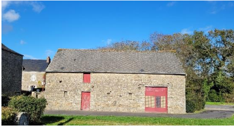
Façade Sud – côté Place Nominoë
