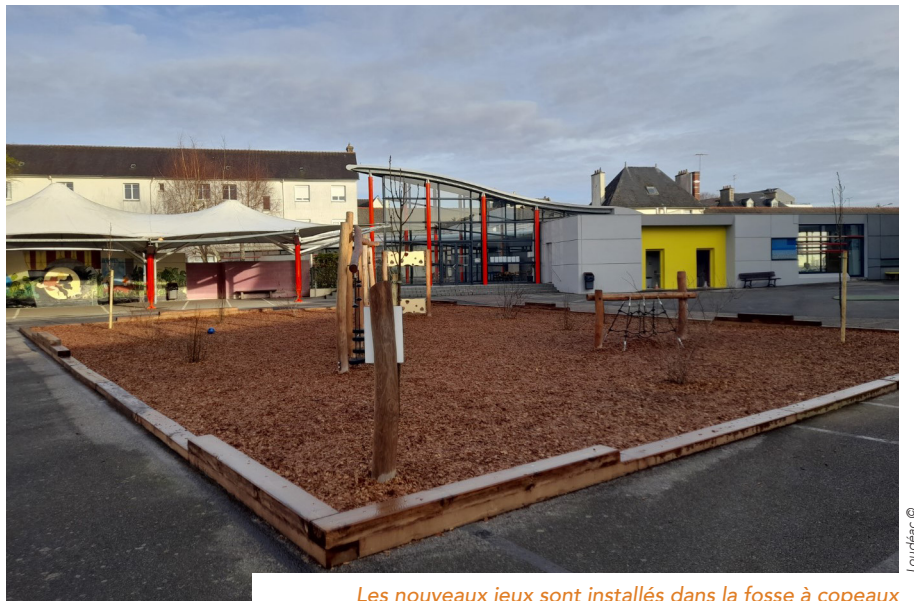
Les nouveaux jeux sont installés dans la fosse à copeaux
