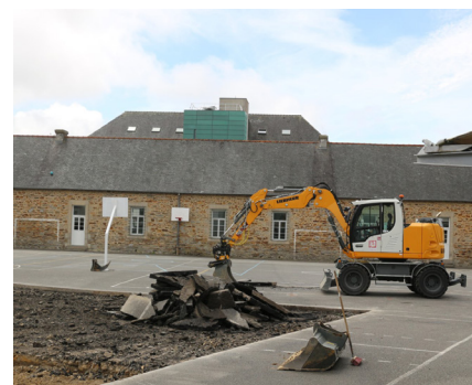
Le dégroutage est réalisé en régie
