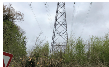
parcelle sous la ligne à haute tension
