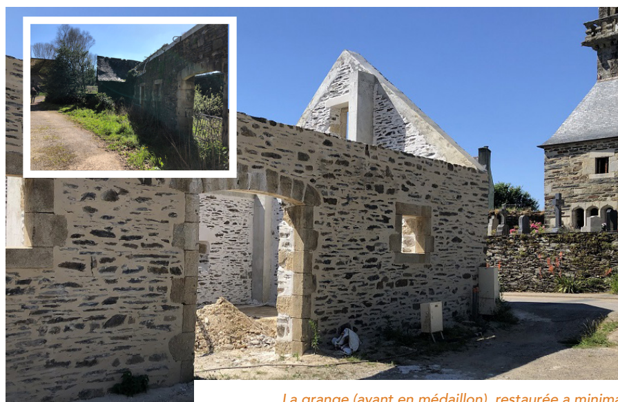
La grange (avant en médaillon) restaurée a minima
