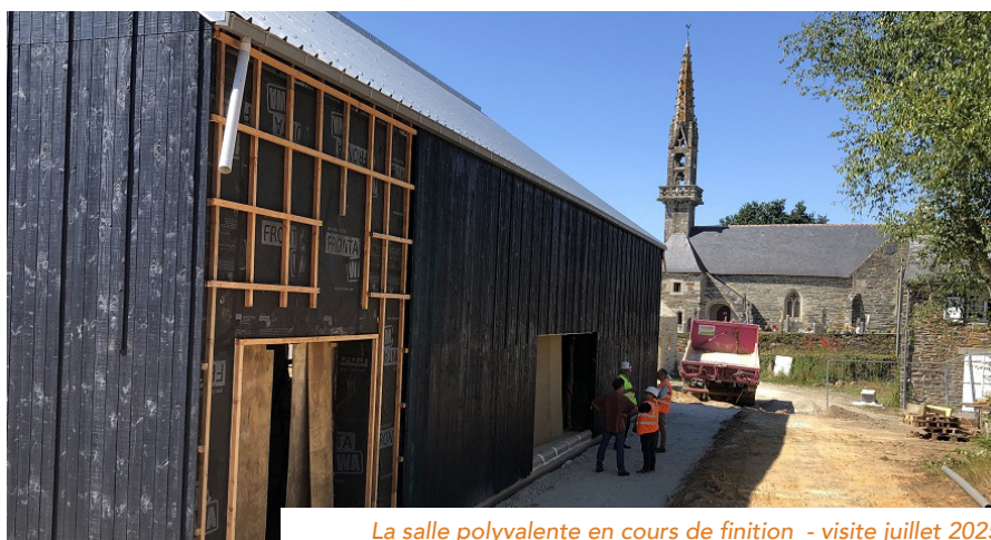
La salle polyvalente en cours de finition - visite juillet 2025
